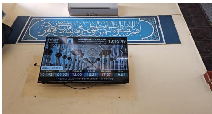
Gambar 6. Display informasi yang telah terpasang
