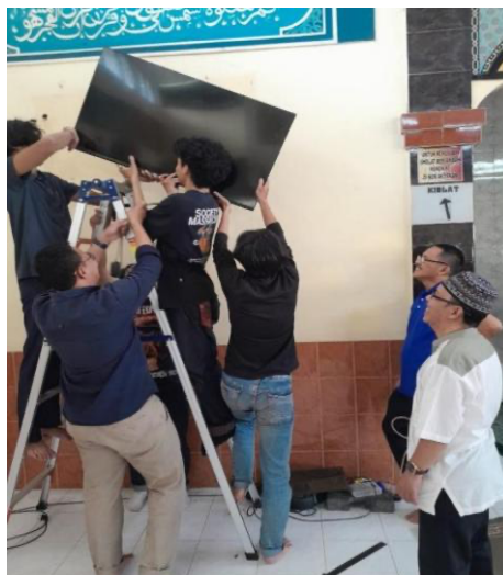
Gambar 1. Pemasangan dan instalasi di masjid Kertamanah
