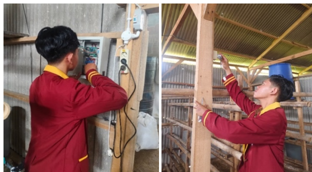
Gambar 3. Pemasangan seluruh komponen perangkat keras
