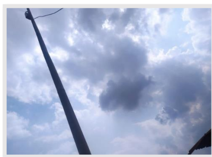
Gambar 4. Pemasangan Router Ditiang
